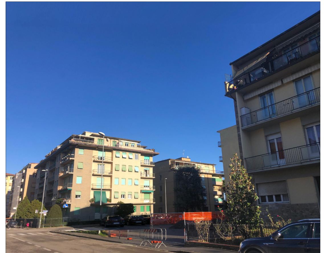
STATO ATTUALE: vista da Via Vincenzo Monti
