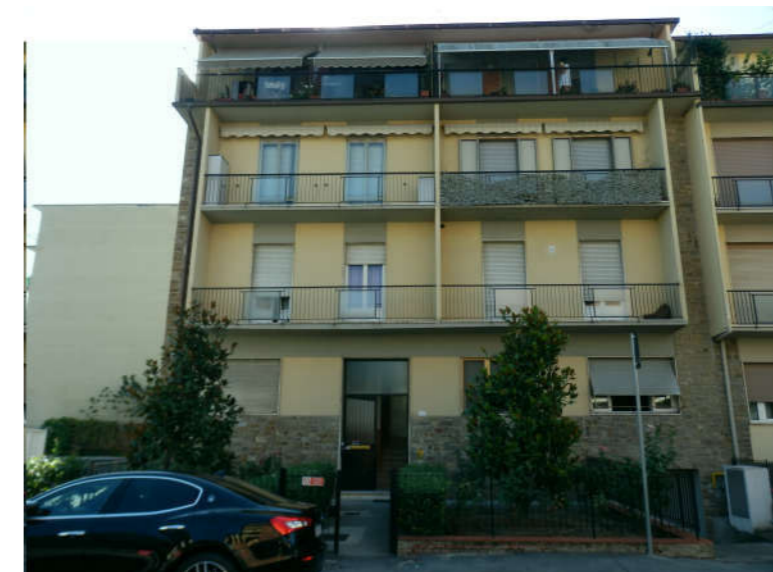
foto 3: facciata fabbricato confinante su Via Vincenzo Monti
