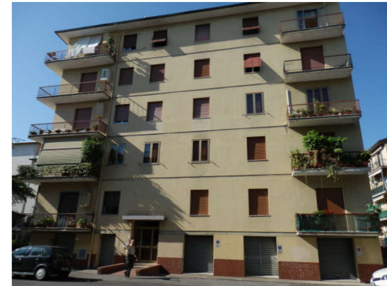
foto 2: facciata fabbricato confinante su Via Edmondo De Amicis
