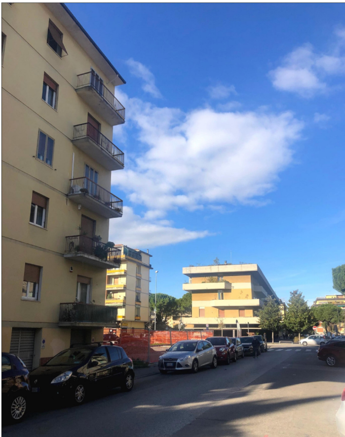
STATO ATTUALE: vista da Via Edmondo De Amicis
