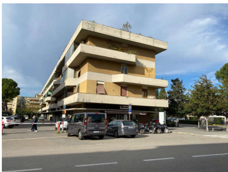
foto 5: fabbricato fronteggiante l'area in oggetto, su Via Vincenzo Monti
