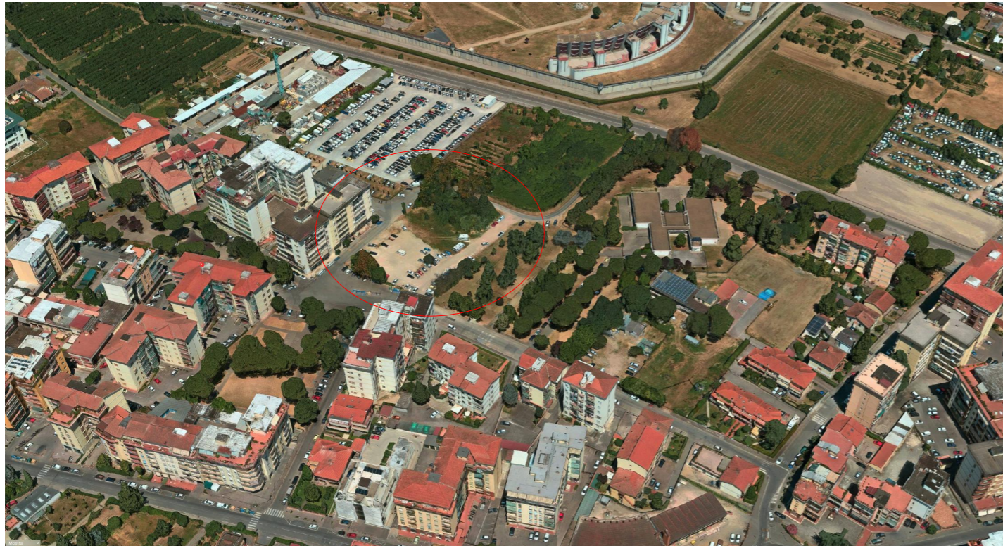
VEDUTA AREA DA SUD
