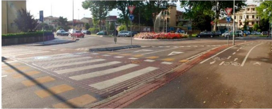
Figura 35 Esempio Attraversamenti ciclabili rialzati
