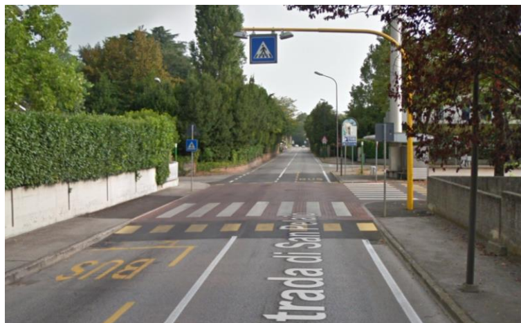
Fig. 26.4 Esempio di incrocio rialzato (Treviso - strada S. Pelajo)
