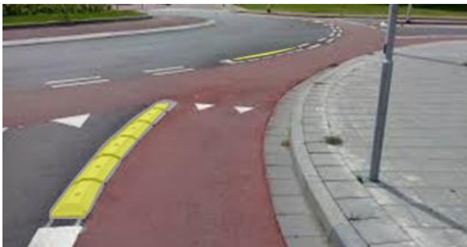
Fig. 20.2 - Protezioni dei percorsi ciclabili "banane vèlo"
