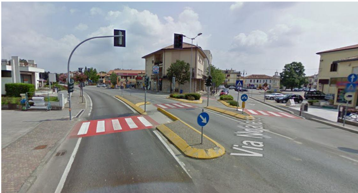
Fig. 28.1 Esempio di attraversamento pedonale con isola salvagente ad uncino (Zero Branco - TV)
