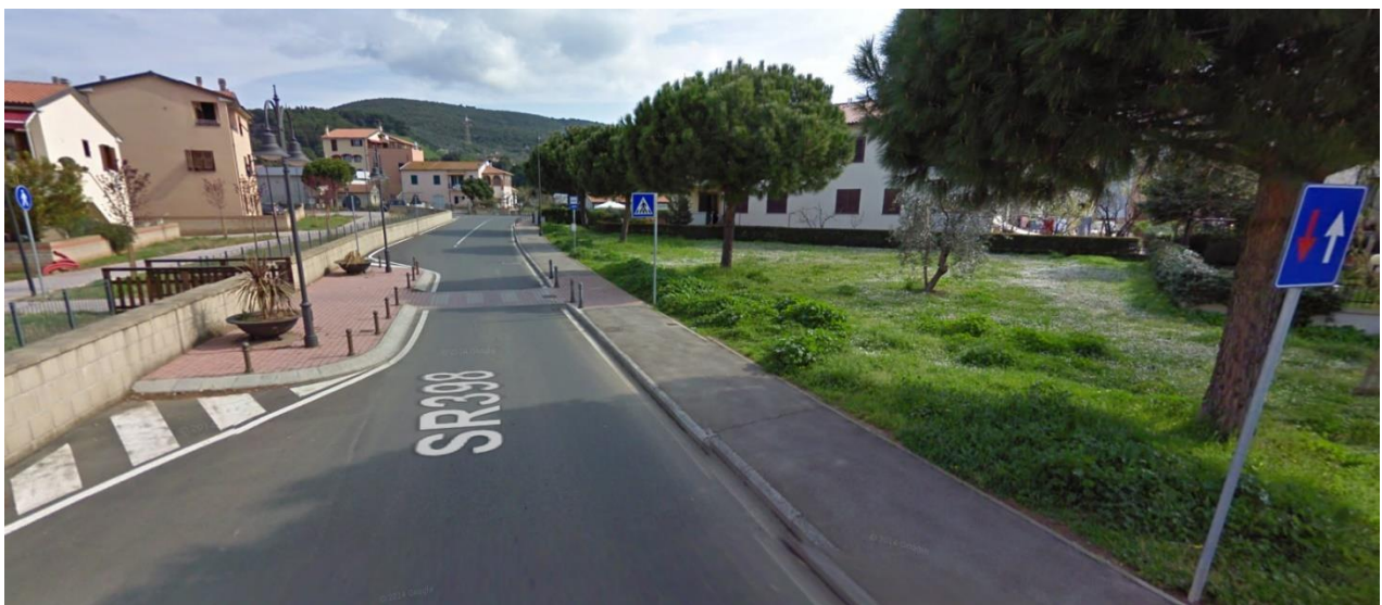
Fig. 26.14 Esempio di attraversamento pedonale protetto da una strettoia con istituzione del senso unico alternato (Venturina - LI)
