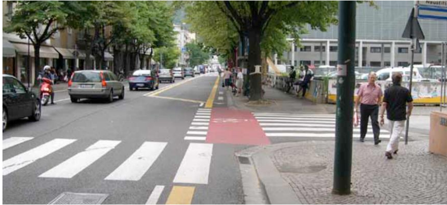
Fig. 23.1 - Esempio di corsia riservata ai velocipedi (larghezza 1 m) accanto ad una corsia riservata bus (3,5 m)
