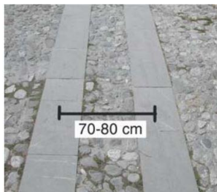
Fig. 27.2 Esempio di acciottolato con fasce di percorrenza
