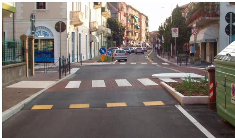
Fig. 26.7 Chicane realizzata con alternanza della sosta e contestuale piattaforma rialzata in bitume (Verona)
