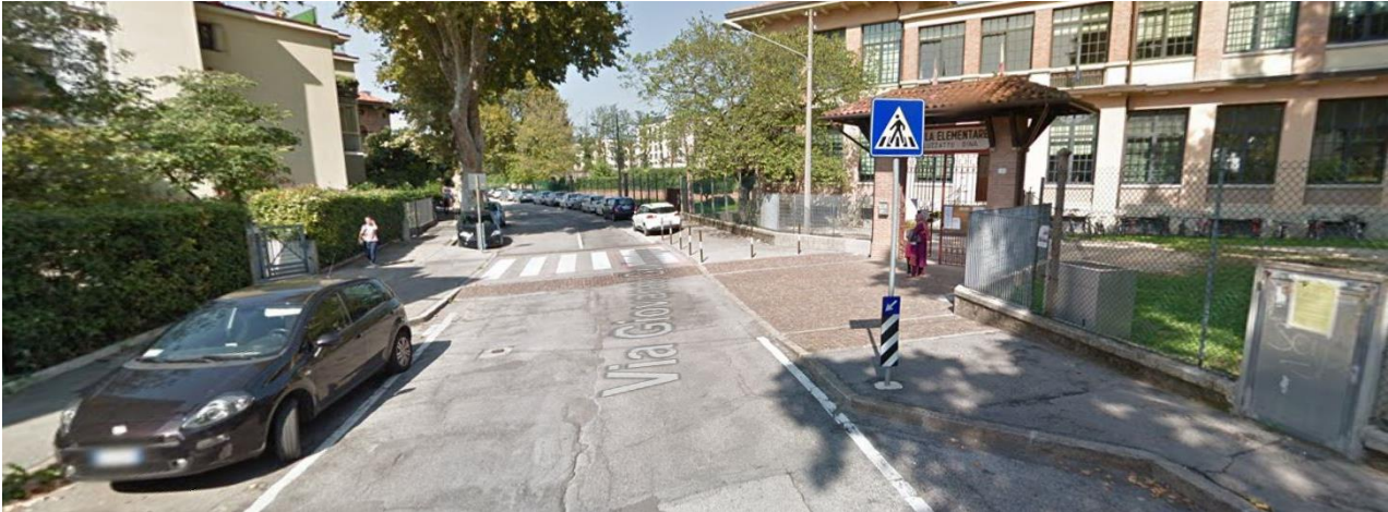
Fig. 26.13 Esempio di restringimento della piattaforma a spese della sosta con avanzamento del marciapiede in corrispondenza di un attraversamento pedonale e piattaforma rialzata (Padova)
