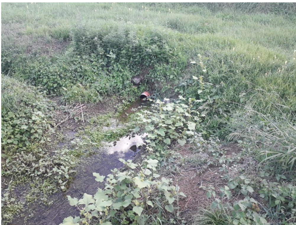
Figura 1-5 – Sifone del torrente Vingone in corrispondenza dell'intervento
