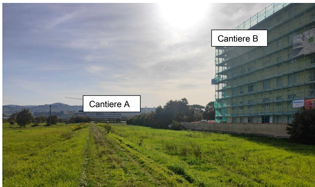
Figura 6: Foto dei cantieri B e A al confine ovest e sud della proprietà.
